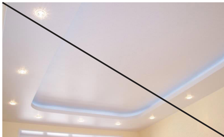
Плохо Многоуровневые гипсокартонные конструкции
