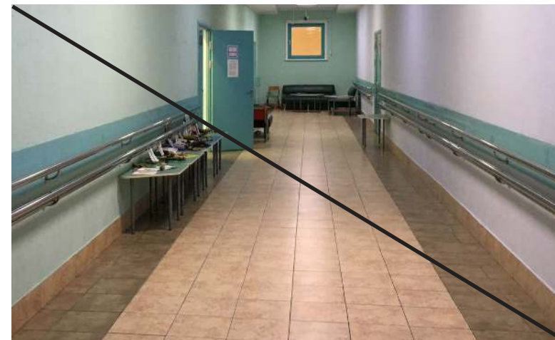
Плохо Керамогранитная плитка с крупными швами
